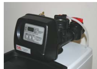
Bilden visar filterautomatik samt förbigångsventil, under den blå kåpan.
