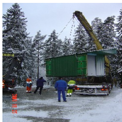
Här lyfts ena halvan av den byggnad, vilken innehåller den nya membrantechnik som renar Åminnebornas vatten på plats. Foto: Bo Fransson
